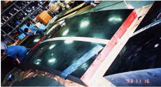
トンネル型枠(パラフィンオイル入りゴム)
