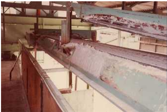
珪砂分離コンベアー部シューター 施工前
