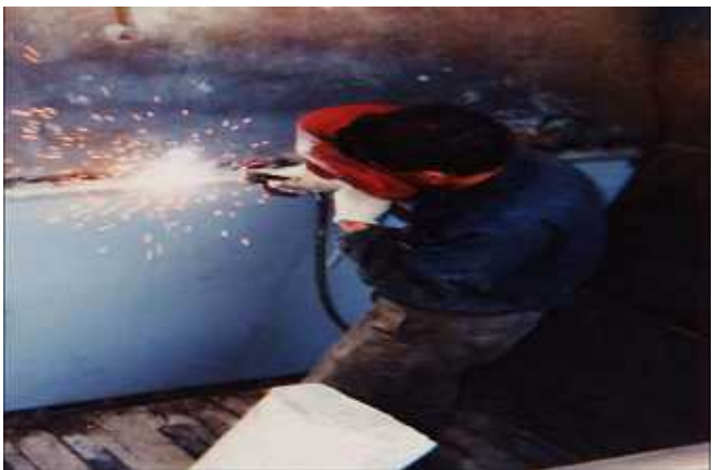
粘土フィーダー鉄板溶接
