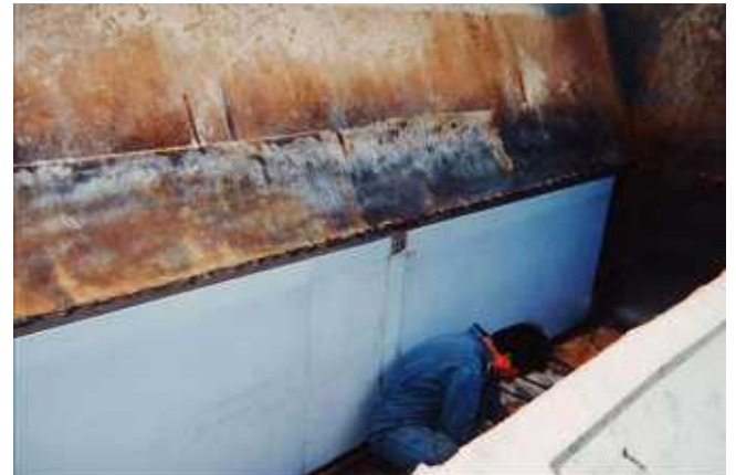
粘土フィーダー鉄板溶接
