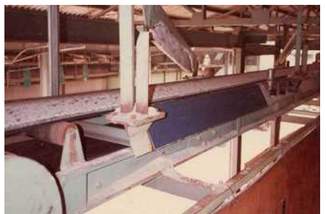
珪砂分離コンベアー部シューター 施工後
